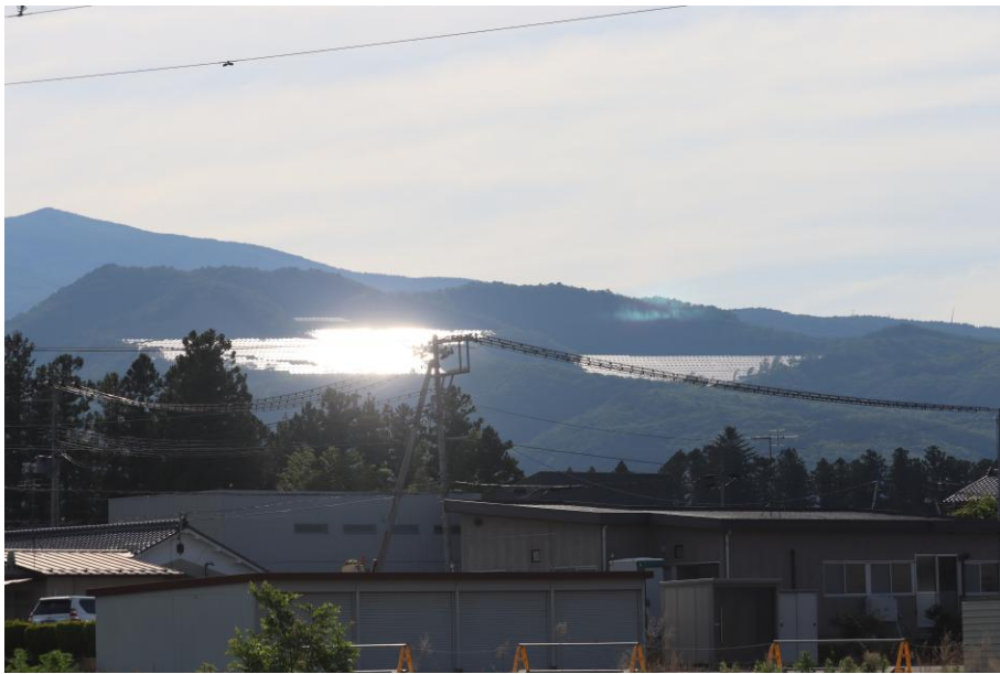
写真 3-1 No. 8-2（福島西工業団地）から見た反射の状況（16:20 撮影）ピーク時
