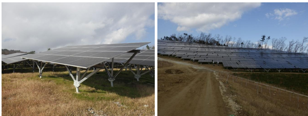
写真1 アレイ群の設置状況
