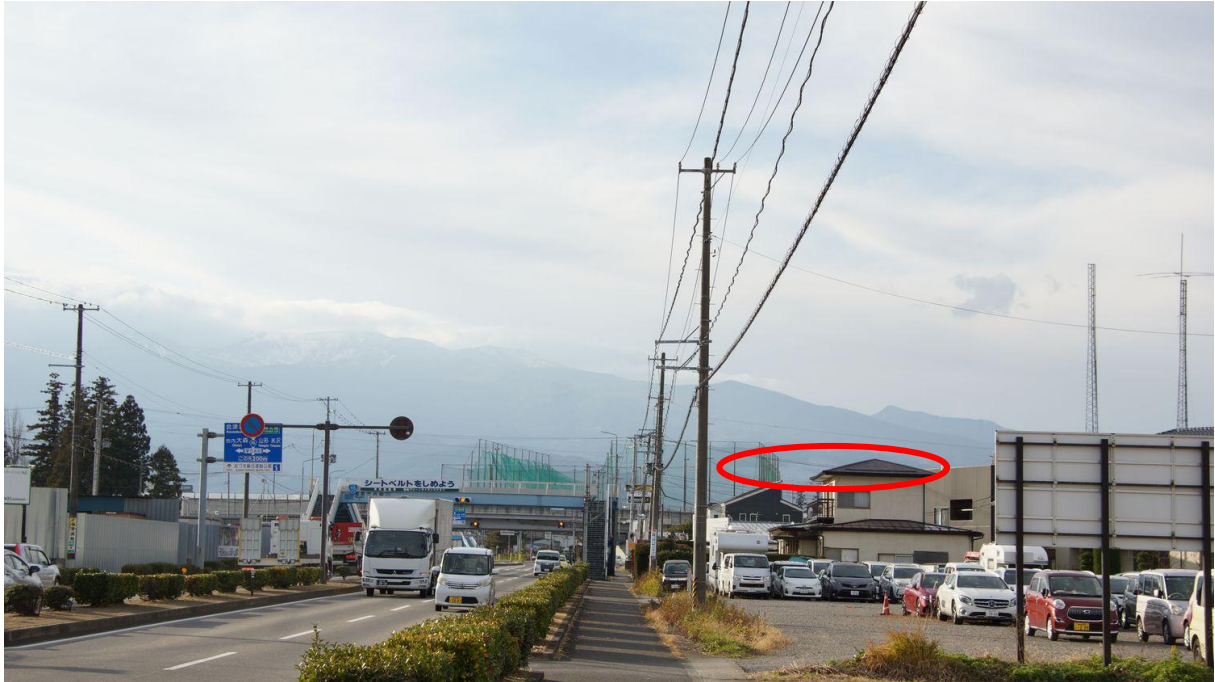
写真7 国道115号沿いからの見え方
