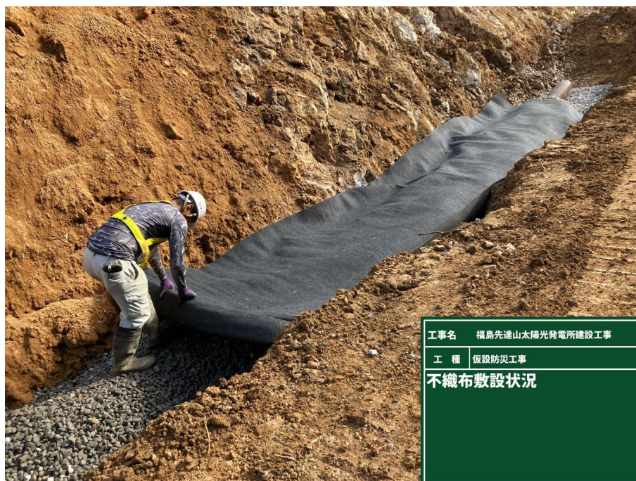
写真 2.3 暗渠排水施工状況 吸出し防止シート設置
