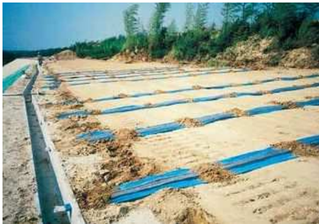
盛土内水平排水
