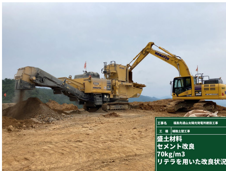
写真-4.1 盛土材料セメント改良状況（リテラ）
