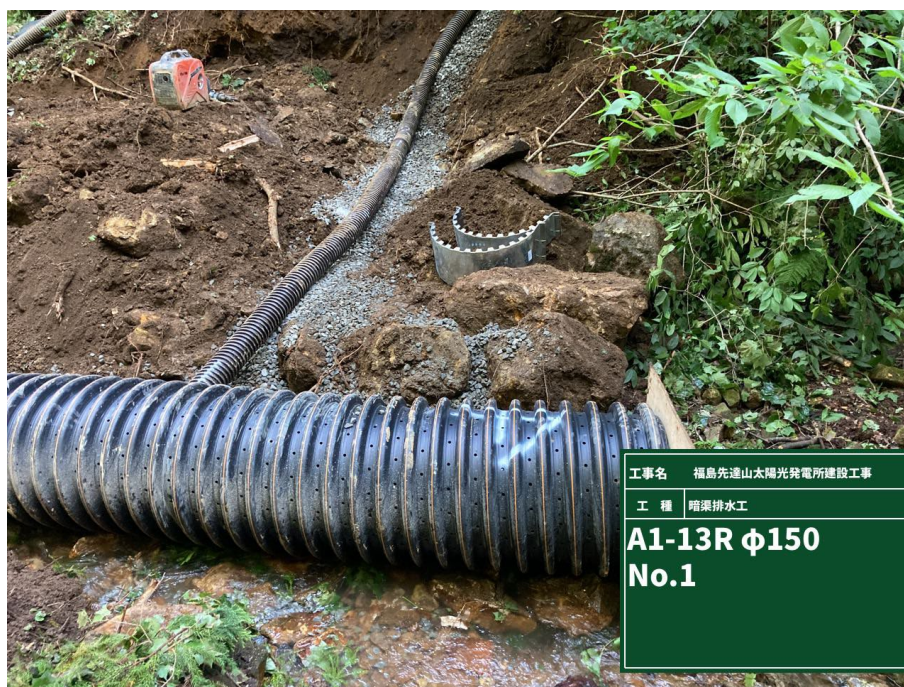
写真 3.1 暗渠排水（支管）施工状況 主管接続
