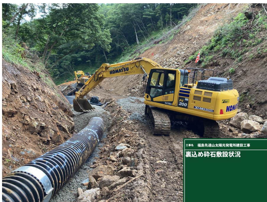
写真 2.2 暗渠排水施工状況 裏込め碎石敷設
