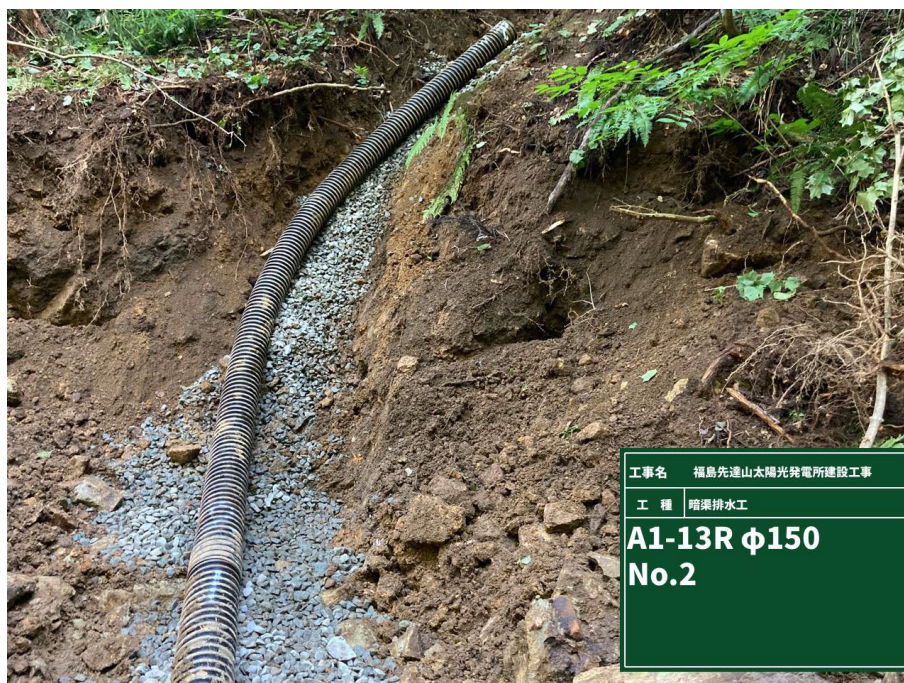
写真 3.2 暗渠排水（支管）施工状況
