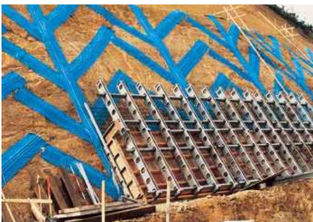
のり面排水および構造物裏込排水
