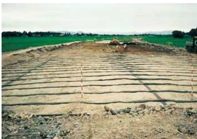
軟弱地盤の圧密水の排水
