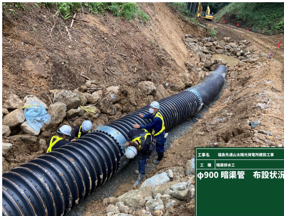
写真 2.1 暗渠排水施工状況 暗渠管敷設
