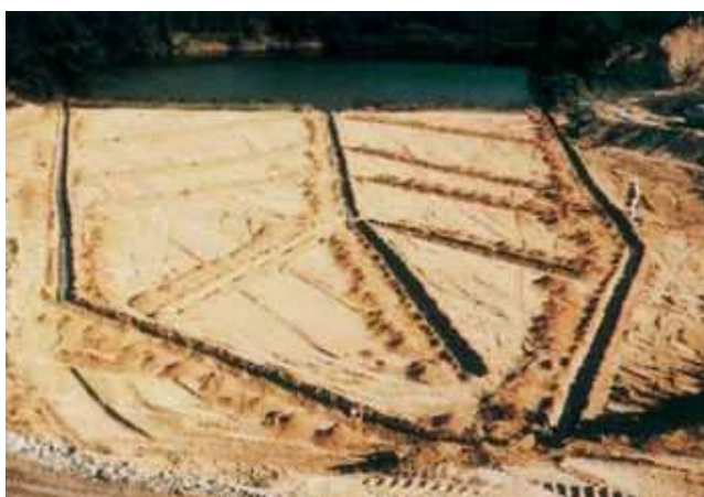
盛土下部暗渠排水
